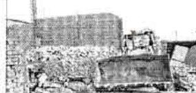
रेवाड़ी में डीटीपी दस्ते ने अवैध निर्माणों को ढहाया।
